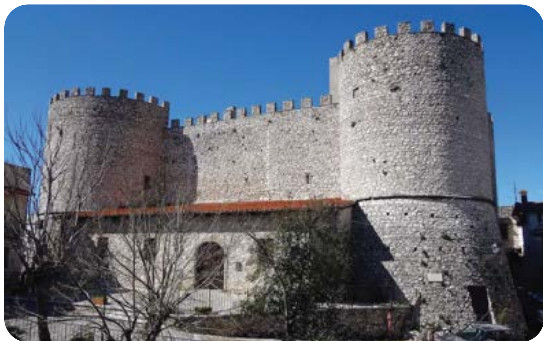
Castello Orsini-Cesi: veduta da Piazza Borghese
