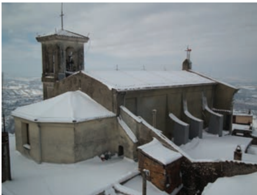
Figura 10 - Chiesa Parrocchiale di S. Maria e S. Biagio: veduta esterna della parte posteriore della chiesa
