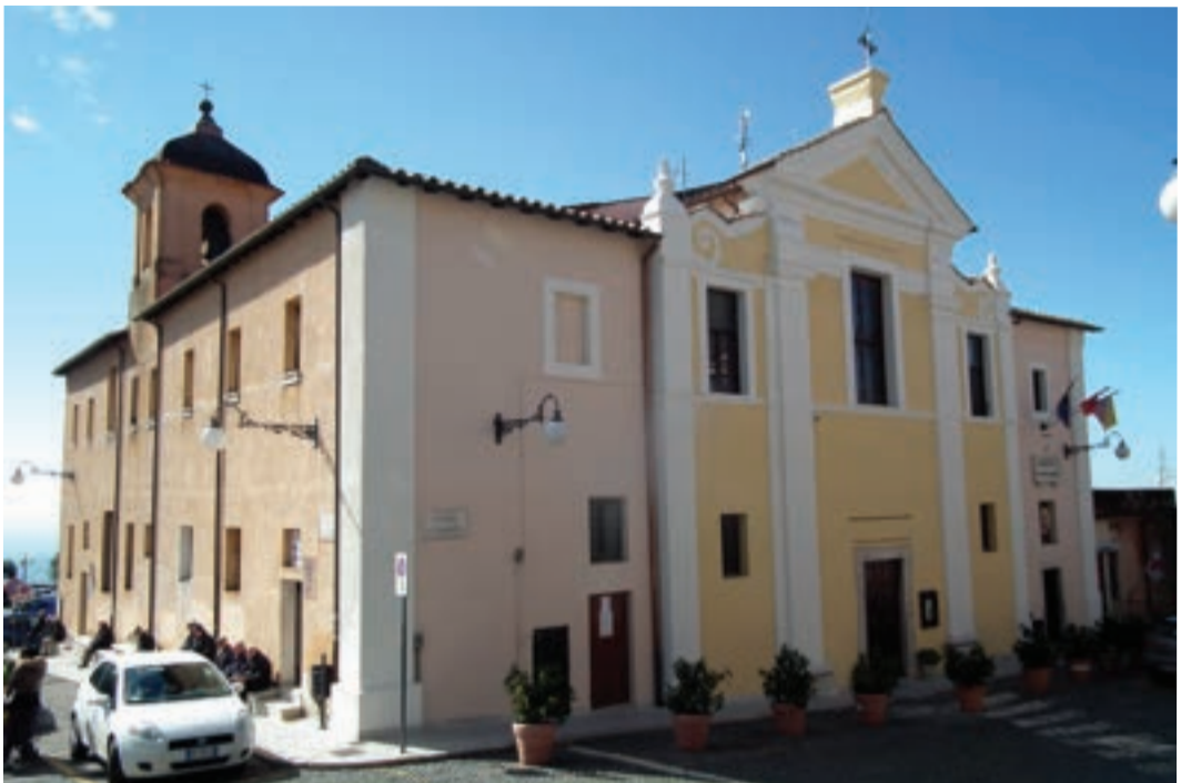
Figura 44 - Palazzo Comunale e Chiesa di S. Liberata: veduta da via Nazionale
