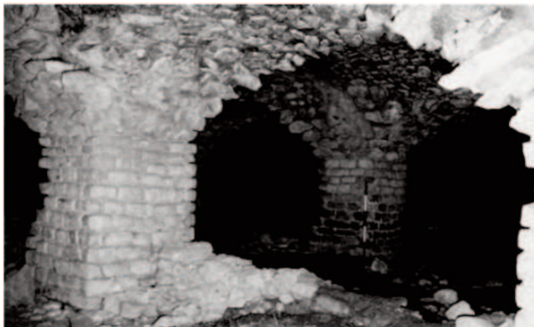
Figura 83 - Cisterna "Le Grotte": veduta interna
