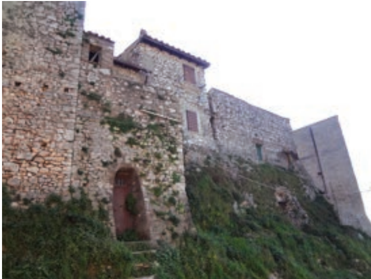
Figura 18 - Cinta muraria medievale: veduta da via Francesco Russi
