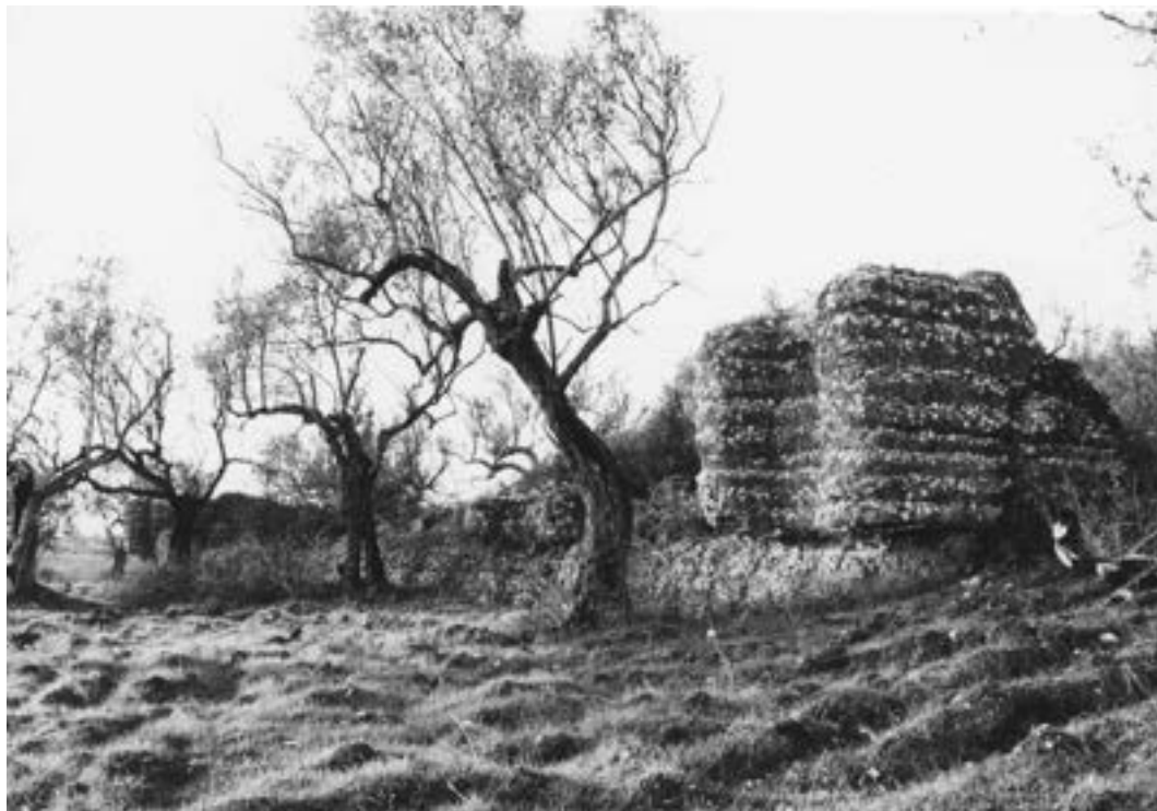
Figura 78 - Villa in località Valle Mara: cisterna
