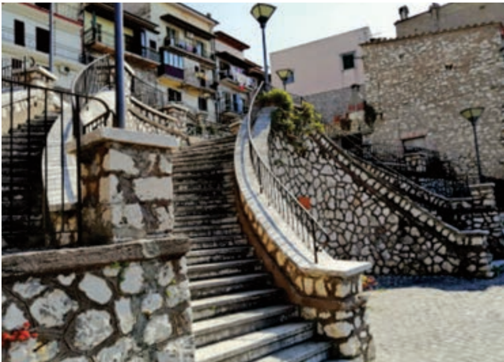
Figura 32 - Scalinata di Largo Belvedere: veduta dal basso, lato sinistro
