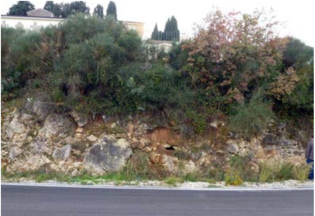
Figura 55 - Soffione di Sant'Angelo Romano: veduta da via Monte Porcello
