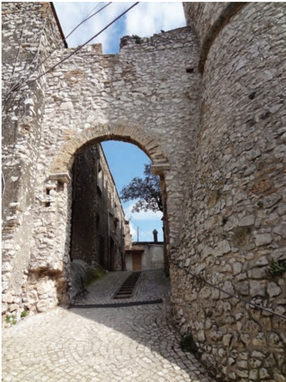
Figura 27 - Seconda Porta di accesso al Castello: veduta da via delle Torri
