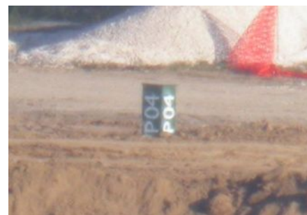
Il piezometro nell'area TMB
