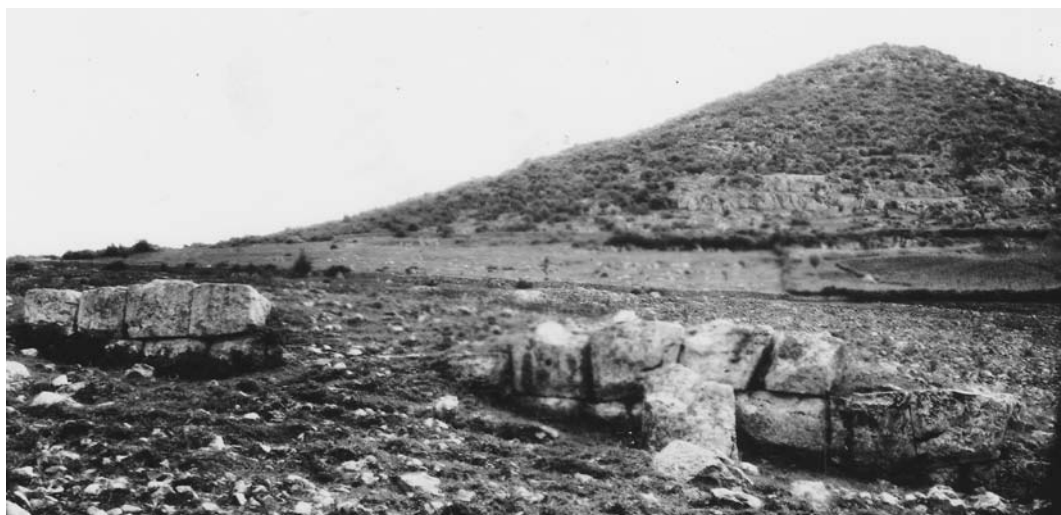
Fig. 23 - Villa in loc. Le Pezze: terrazzamento (foto Th. Ashby, 842).
