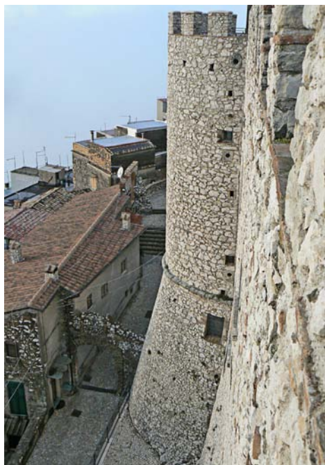
Fig. 32 - Torrione a Nord-Ovest con fori e feritoie per il puntamento delle armi da fuoco.
