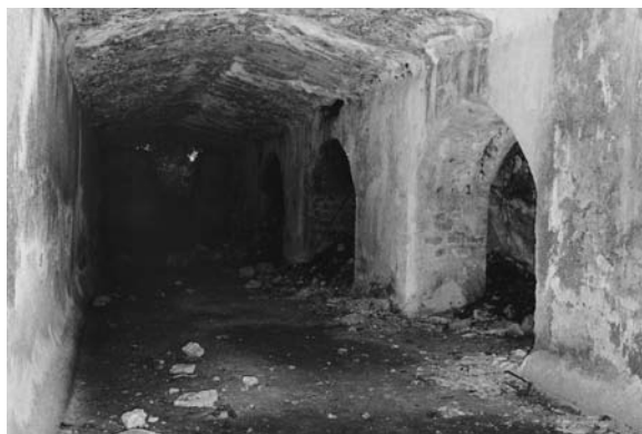
Fig. 20 - Villa in loc. Macchia di S. Angelo (Poggio Cesi): cisterna.
