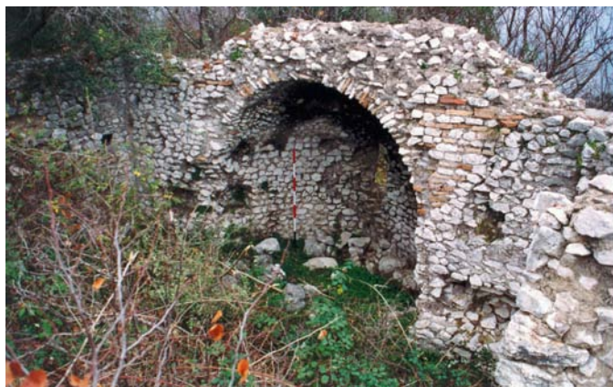
Fig. 44 - Poggio Cesi: parte absidale della chiesa di S. Nicola.
