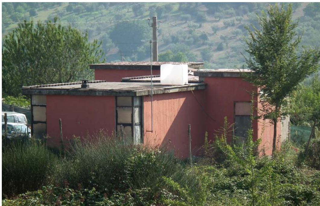
Fig. 1 - L'edificio in cemento armato, di proprietà ACEA ed in via di acquisizione comunale, che potrebbe ospitare il Museo naturalistico del Carsismo e dell'Acqua (Foto M. Giardini).
